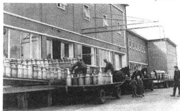
Aanvoer van de pullen
